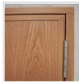
Detalle esquina cara interior
